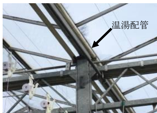
温湯による融雪装置の事例
