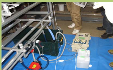
コントローラー設置～試運転
