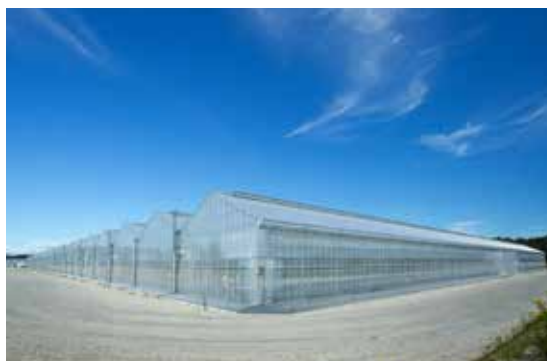
高軒高連棟型ハウス
