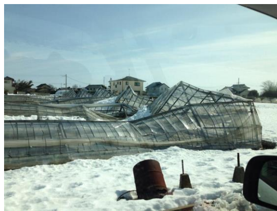
台風や大雪で被害を受けたハウスの被害事例
