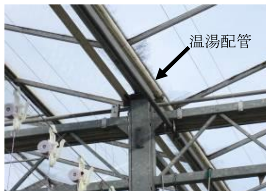
温湯による融雪装置の事例
