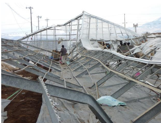
台風や大雪で被害を受けたハウスの被害事例
