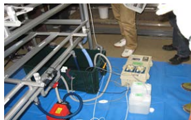
コントローラー設置～試運転
