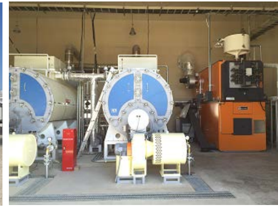
木質チップボイラー1基 LPGボイラー2基
