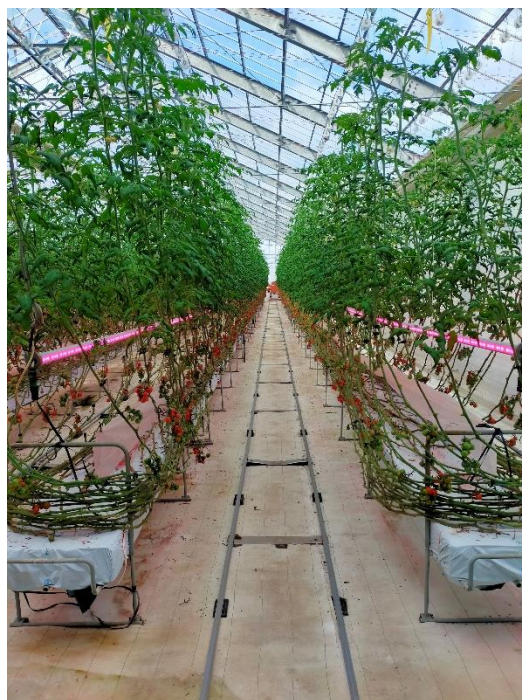
作業用レールおよび送風ダクト 出所：植物工場研究会撮影
