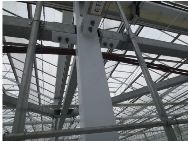
図6 白色コーティングした鉄骨柱材 光反射による光の有効利用と骨材の高温化の抑制のため
