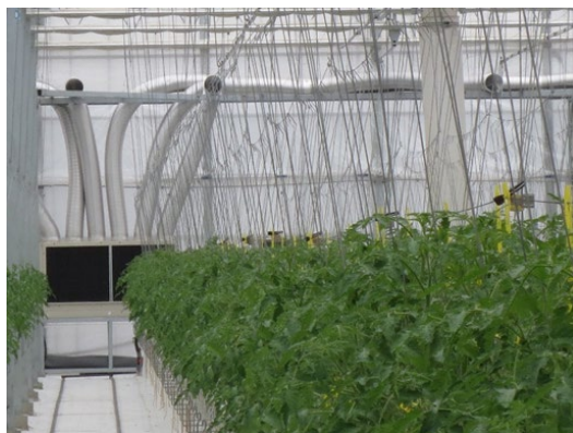
図 10 ミニトマト夏越し栽培でのヒートポンプ利用 夏越し栽培での夜間冷房と、冬期の暖房に利用(次世代施設園芸愛知県拠点)
