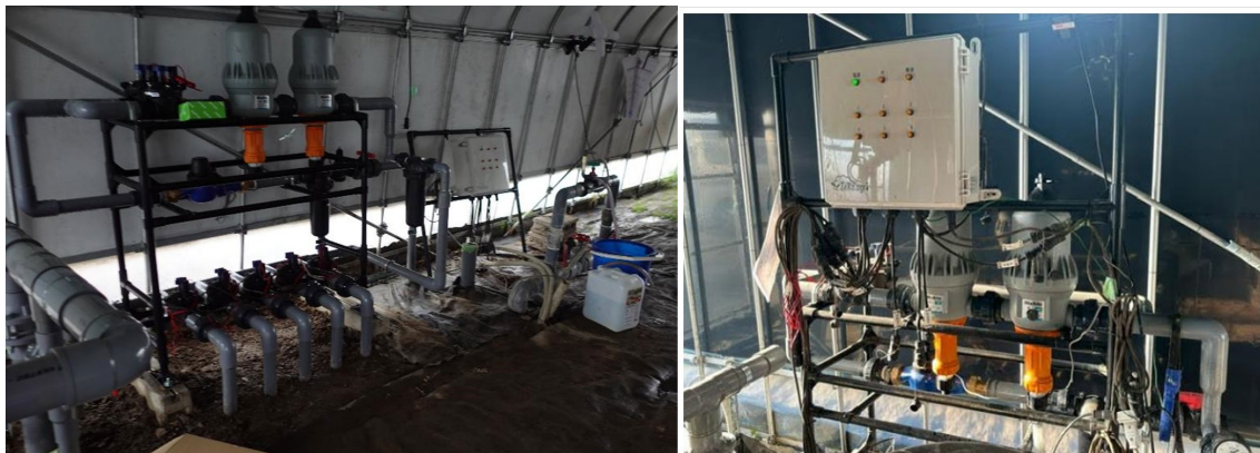
図7 左:液肥混入機、右:灌水コントローラー(ゼロアグリ)
