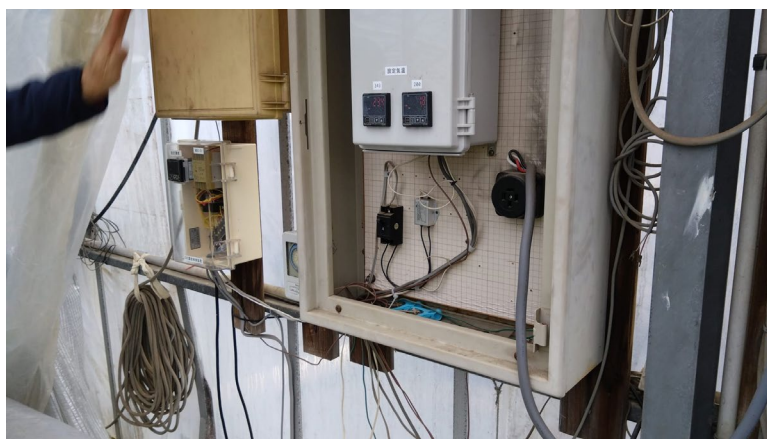
図 4 CO 2 濃度コントローラ
