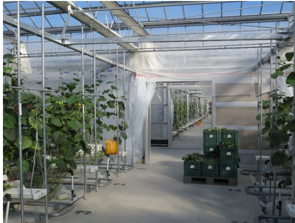
図7 既設と新設ハウスの連結部
