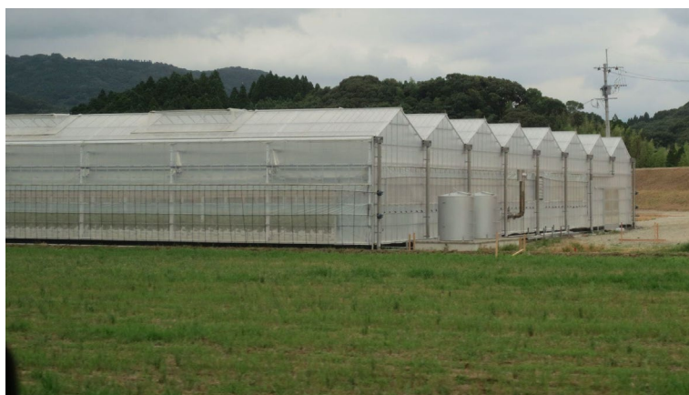
図2 2020年に建設した23aのフェンロー型ハウス(軒高4m) 養液栽培がし易いように2屋根間口を9mにした 2023年に手前の土地に32haの同型ハウスを増設
