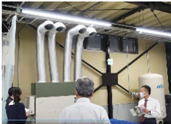
図4 選果場に設置されたヒートポンプ室内機 (高温期の果実品質維持のため他の農場より移設し冷房利用)
