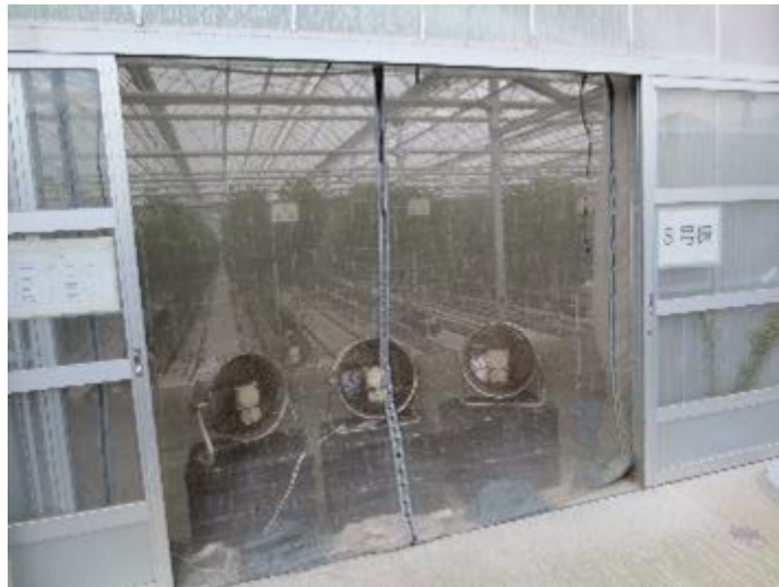
図4 試験中の外気導入用ファン
