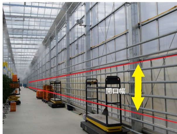
図3 周壁に巻き上げ式換気窓を取り付けた高軒高フェンロー温室(軒高7m)
