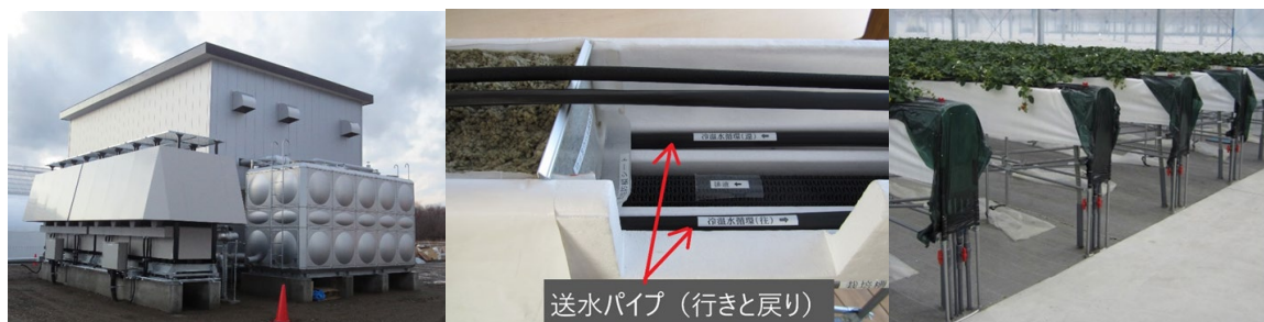
図 11 ヒートポンプによる四季なりイチゴ栽培の培地冷却の事例
