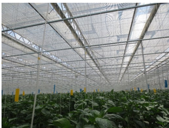
図6 編込遮光資材(アルミ箔および透明割繊維の編込み)を利用した内部遮光カーテン 換気されるように、全閉にしないで数十cm幅のカーテン開部を残す
