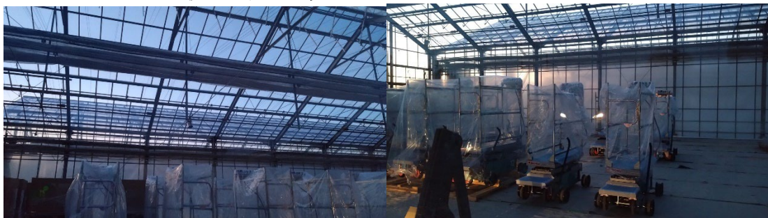
図3 リノベーション後のハウス内部
