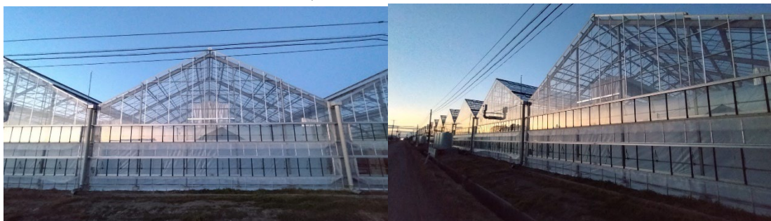
図2 リノベーション後のハウス外観
