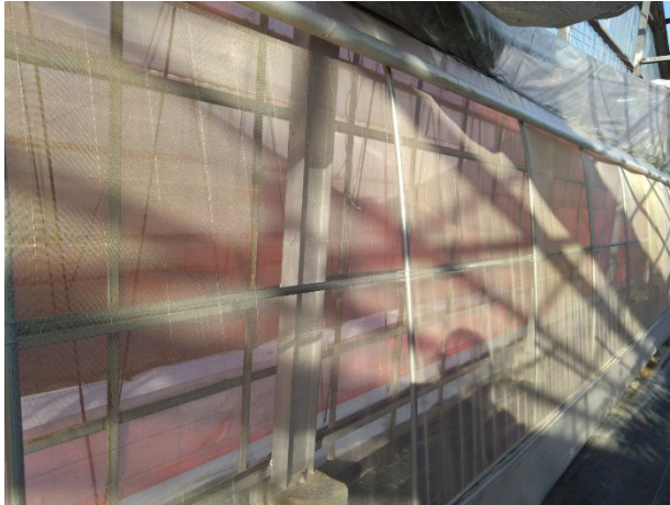
図9 吸気側サイドの内側にパイプによる張り出し構造を追加工事し、防虫ネットを2重展張したエアチャンバーエリア。内部にミストノズル配管を設置。
