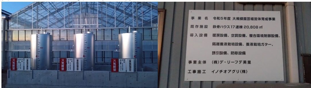
図4 左：リノベーション後の重油タンク、右：事業内容
