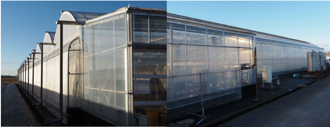
図3 ハウス妻面と張り出しおよび下屋（左）とハウス側面と張り出しおよび下屋（右） ハウス外張りフィルムは屋根面（フッ素樹脂フィルム・散乱光タイプ）とサイド（農P0フィルム）とも張り替えを行った。
