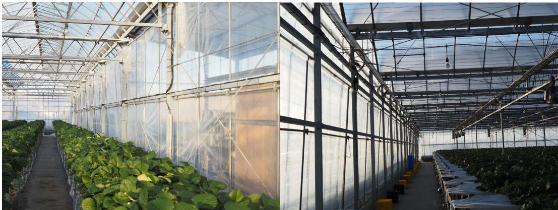
図4 ハウス内部の側面（左）と妻面（右）の内張りフィルム いずれも農P0フィルムでの張り替えを行った。その他、カーテン装置のワイヤーとカーテン資材の張り替えを行った。
