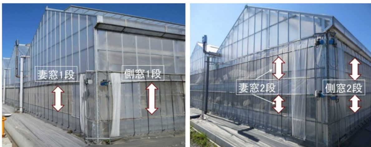
図2 多連棟温室の巻き上げ式換気窓の開口幅の違い
