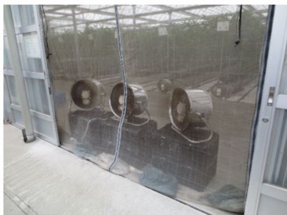
(b) 外気導入効果を試験中。左写真の妻面内に設置したファンで外気導入を促進し、右写真のダクトファンで温室中央方向へ送風(次世代施設園芸埼玉県拠点)
