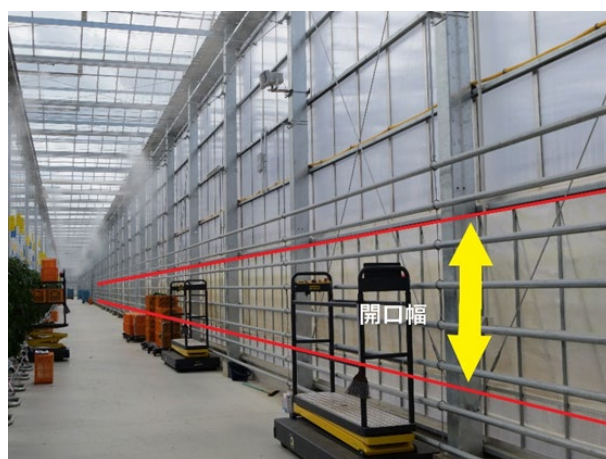
図3 周壁に巻上げ式換気窓を取り付けた高軒高フェンロー温室(軒高7m)
