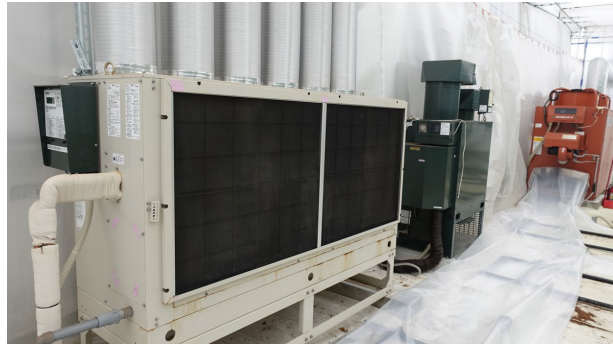
図2 高軒高ハウスの暖房設備
