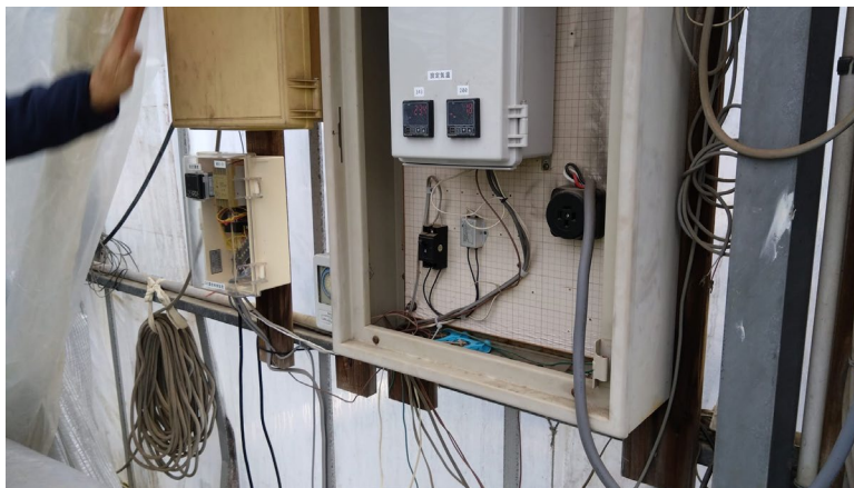
図4 CO 2 濃度コントローラ
