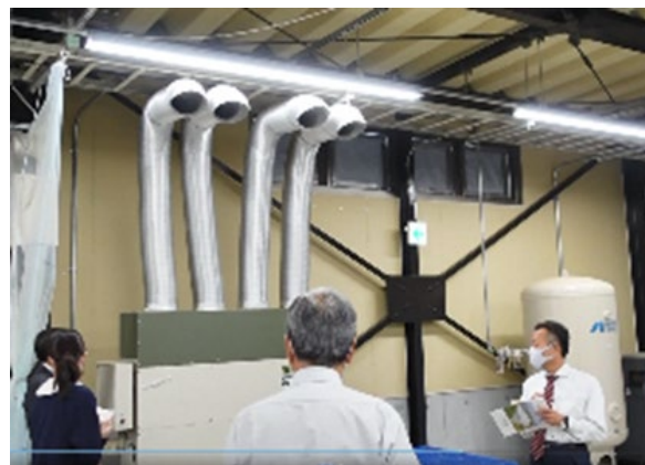
図4 選果場に設置されたヒートポンプ室内機 (高温期の果実品質維持のため他の農場より移設し冷房利用)
