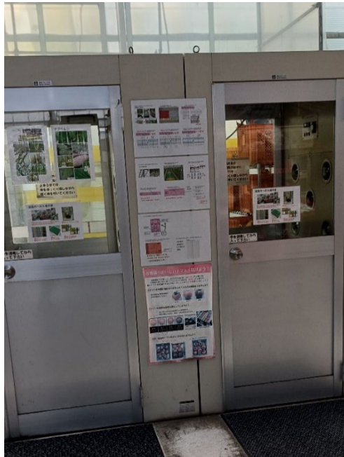
世羅菜園施設 栽培室入口エアシャワー 出所：植物工場研究会撮影
