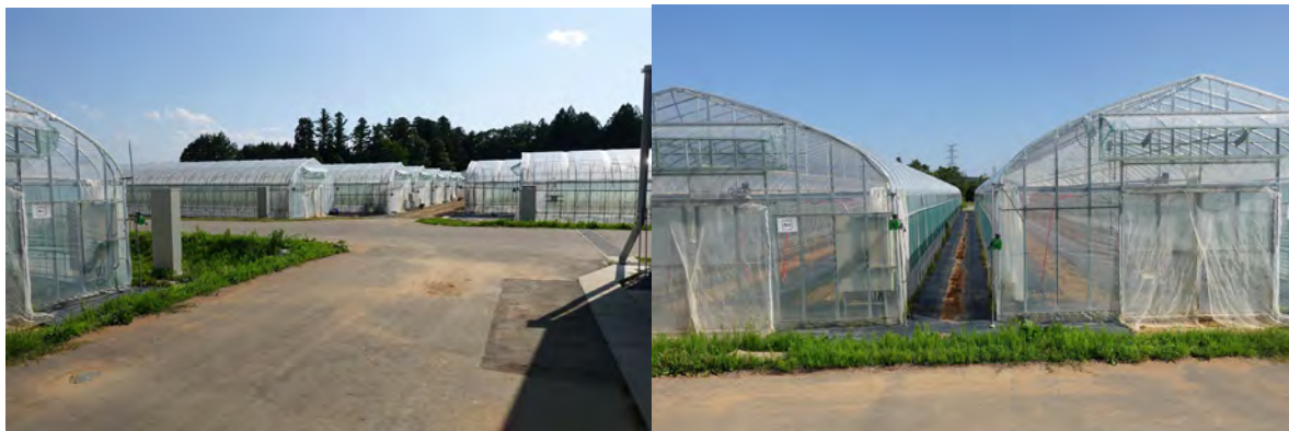
図2 単棟パイプハウス群(左)と側窓自動換気装置(右)
