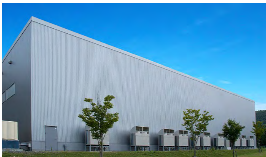
図1 (株)ツバキベジムーブ小浜第1工場全景
