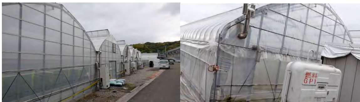
図3 連棟鉄骨ハウス(外張被覆資材 左:梨地フッ素樹脂フィルム、右:農POフィルム)
