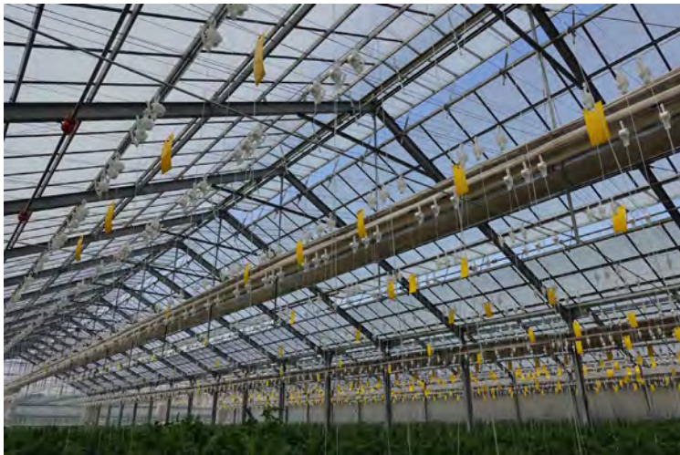
図4 遮熱剤を塗布した屋根面と天窓、中天窓、カーテン装置の状況
