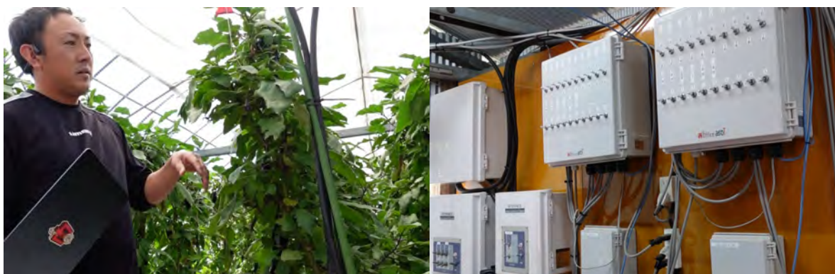
図8 シンプルな葉かき作業でLAIを管理する独自の仕立て方(左)と、 (株)分ち合ふ農園と同機種 of 安価な統合環境制御装置(右)
