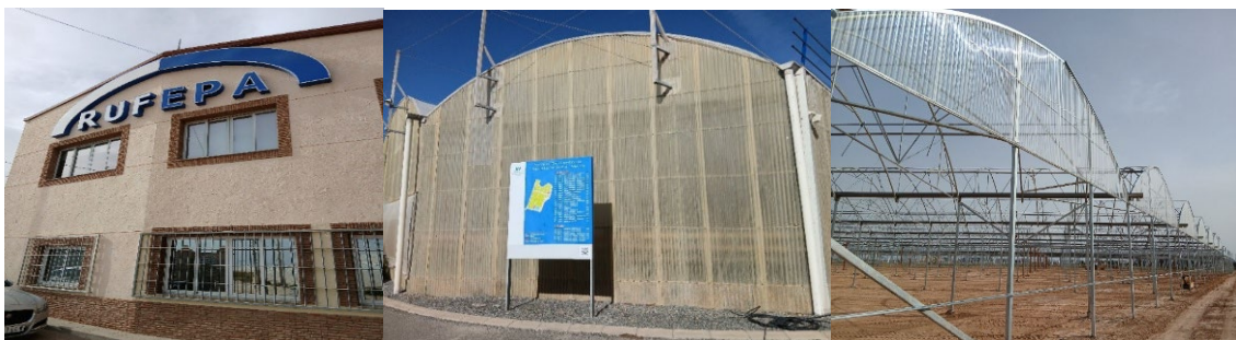
図6 ルフェパ社（左）と新たに建築中のビニール温室の様子（右）
