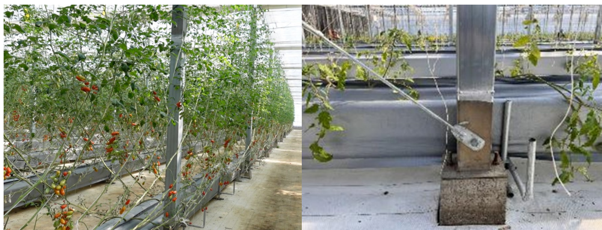
図 嵩上げた中柱（左、上部の白い部分が接合部）と基礎上の接合部（右）
