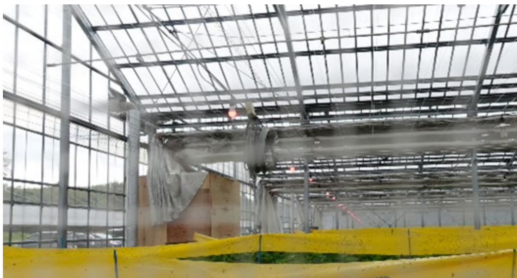
図1 開口部付近に設置された防除用赤色LED灯、黄色粘着テープ
