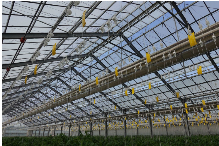
図4 遮熱剤を塗布した屋根面と天窓、中天窓、カーテン装置の状況
