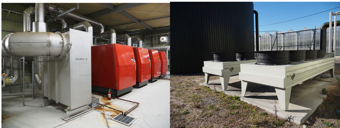
図3 潜熱回収型温湯ボイラーとCO 2 排気ダクト(左)とCO 2 徐熱用ドライクーラー(右)
