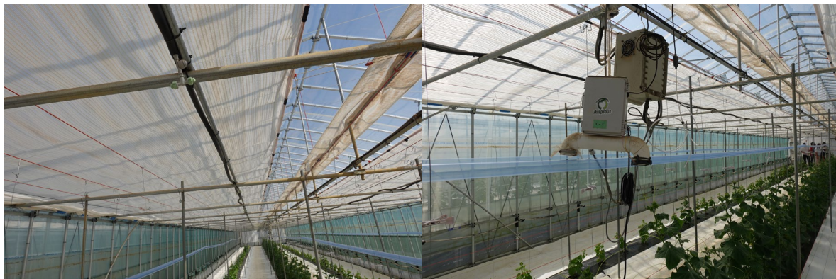
図3 単棟パイプの遮光カーテンとミスト装置(左)と試験用の環境モニタリング用センサー類(右)
