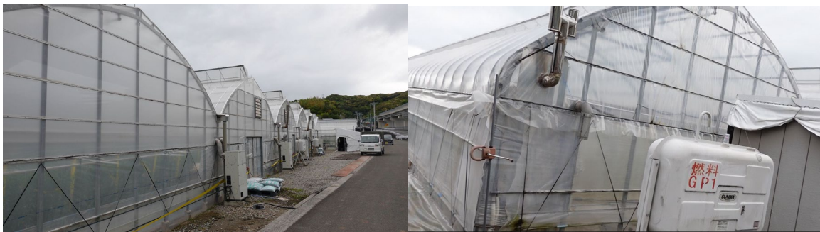
図3 連棟鉄骨ハウス(外張被覆資材 左:梨地フッ素樹脂フィルム、右:農POフィルム)
