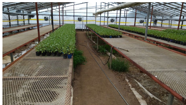
図4 育苗用の単棟木骨ハウス内部
