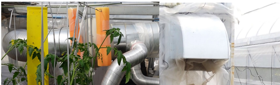
図9 外気導入装置(左、中央部が射流ファン)と外気取り入れ口(右)
