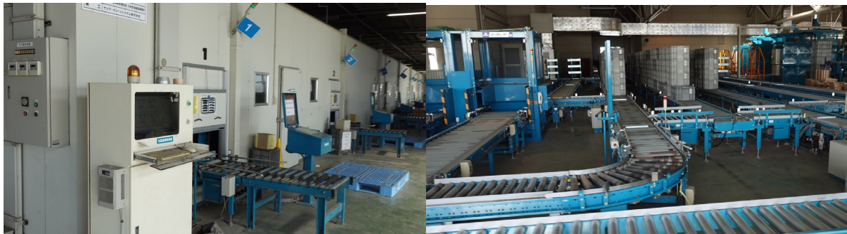
図9 JA選果場1階の荷受け兼予冷施設(左)と2階のエレベーター施設や搬送レーン(右)
