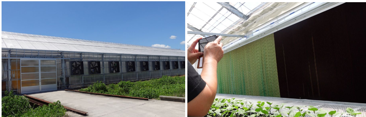
図10 鉢上げ用ハウスのファン(P&F用)と外部遮光(左)とパッドの色の差(右、左側:地下水質の影響で緑色に変色した箇所、右側:新品箇所)
